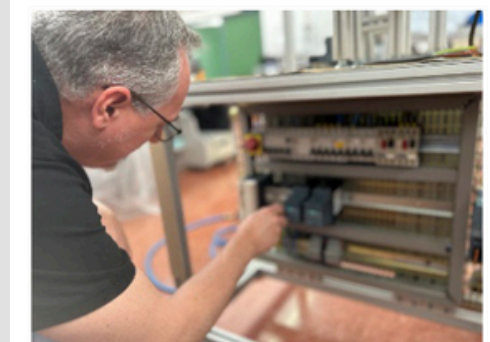
Ilustración 4. Montaje del cuadro eléctrico
